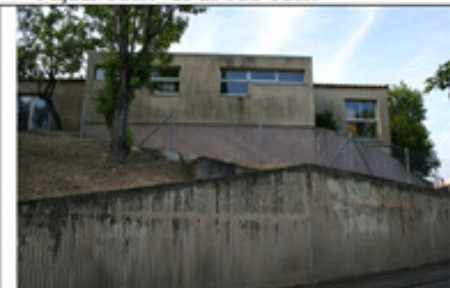
Autre partie de la façade Nord
