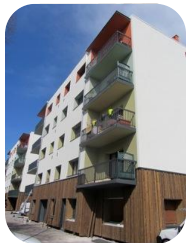
Vue après travaux
